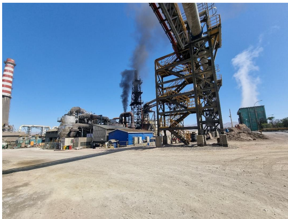
Figura 4.48: Humo negro producto de la quema de combustibles fósiles, cuya liberación ocurre por la quema de hidrocarburos para dar partida al horno de refino a fuego. El humo blanco corresponde a vapor de agua de la planta de ácido. (Elaboración Propia, 2023)
