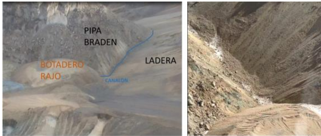
Figura 29: Vista del canalón e intervenciones en superficie (GRMD-DET, 2019)
