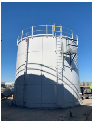
Figura 5.12: Estanque de agua (50,000 [Gal]).
