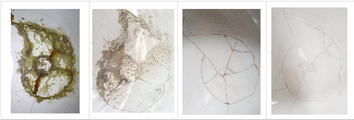
Figura 42. Detalle de las etapas de intervención interior y resultado final.
