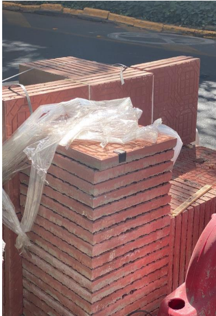
Pastelones de “Baldosa Chocolate” apilados para ser instalados. Fotografía de la autora (2023)
