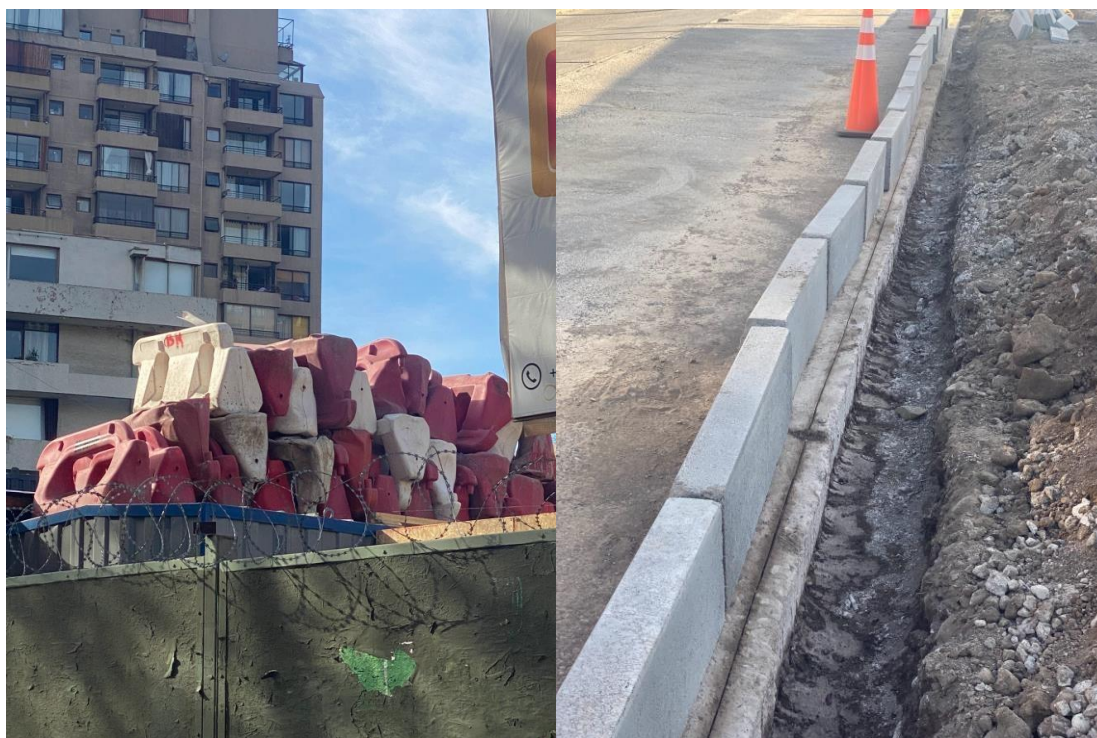
Fotografía izquierda, vallas “New Jersey” almacenadas sobre un container. Fotografía derecha, soleras de hormigón listas para ser instaladas. Fotografías de la autora (2023)
